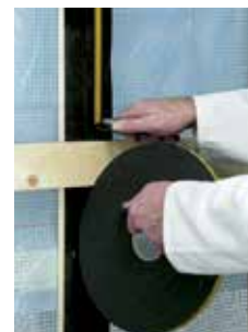
Voorbehandeling achterzijde met Easy Clean Wipes of Primer PanelTack
