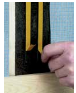
Voorbehandeling achterzijde met Easy Clean Wipes of Primer PanelTack
